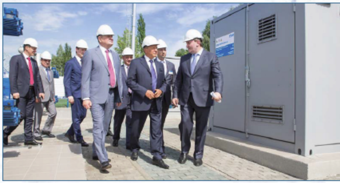
На АГНКС установлены энергоэффективные компрессоры повышенной мощности и высоконадежная автоматизированная система управления
